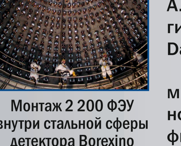
Монтаж 2 200 ФЭУ внутри стальной сферы детектораorexino
